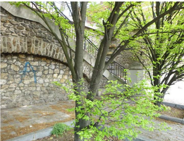
Base du mur de quai – emplacement du futur puits
