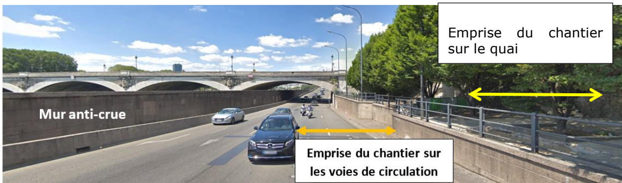
Figure 23 – Position de l'emprise de chantier par rapport au mur anti-crue de la voie Mazas
