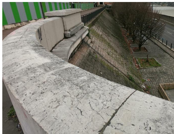
Angle pont d'Austerlitz
